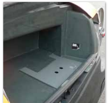
Wartungsfreie Batterie: frostgeschützte Aufstellung und problemlos erreichbar
