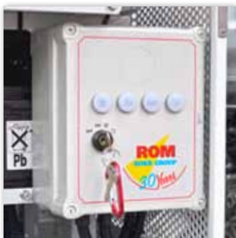
Bedienkasten der Motor-/ Pump kombination
